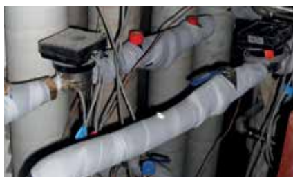
Балансировочные клапаны Danfoss ASV и термостаты CWD установлены в каждом техническом помещении для каждой группы из четырех квартир.
