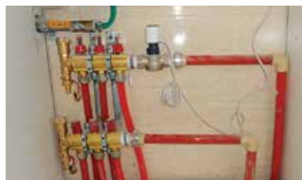
Коллектор Danfoss с клапаном RA-G и приводом TWA-A. Эта комбинация была установлена в квартирах меньшего размера, чтобы обеспечить централизованный температурный контроль при помощи терморегулятора CWD в главной жилой комнате. Более просторные квартиры были оборудованы средствами регулировки температуры в отдельных комнатах.
